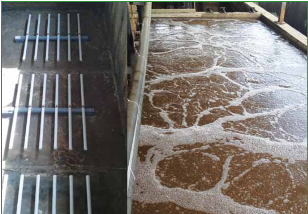
Рис. 7. Раскладка системы на основе аэраторов OTT MAGNUM (слева) и аэротенк после реконструкции (справа)
