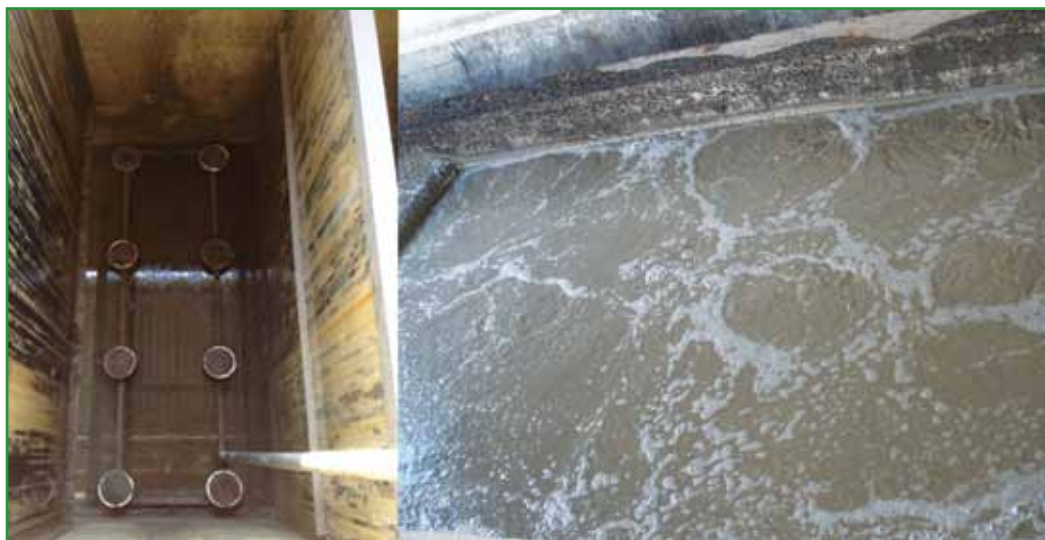
Рис. 5. Аэротенк с дисковыми аэраторами до реконструкции
