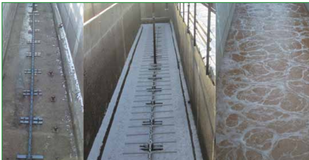
Рис. 3. Монтаж новой системы аэрации на целлюлозно-бумажном комбинате (слева и в центре – монтажные работы, справа – эксплуатация после завершения монтажа)
