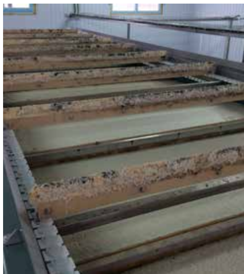
► Рис. 5. Скребковый механизм
