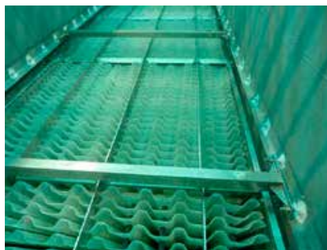
► Рис. 2. Примеры использования пластин во флотационном резервуаре
