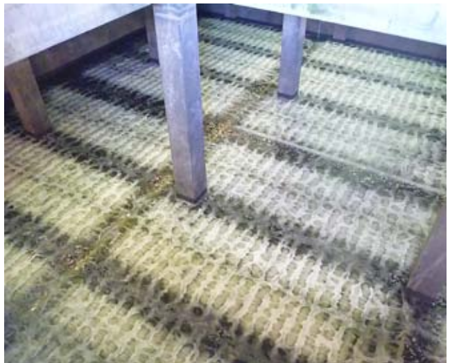
Рис. 4. Равномерность образования пузырьков воздуха и распределения воздуха по всей длине аэрационной плети
