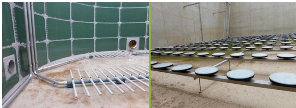
Рис. 1. Трубчатые мембранные аэраторы OTT MAGNUM с мембраной FLEXSIL (слева) и дисковые аэраторы OTT D-Rex с мембраной FLEXLON (на основе силикона) на очистных сооружениях промышленных стоков
