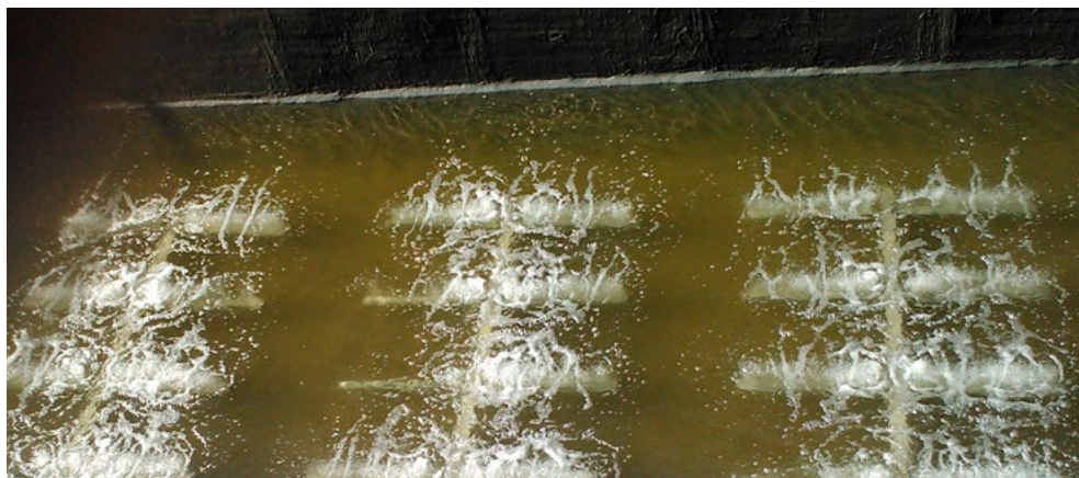
Рис. 3. Пример неравномерного распределения воздуха в аэрационной системе
