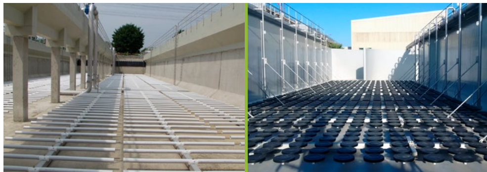
Рис. 2. Сравнение вариантов раскладки аэрационной системы на основе трубчатых (слева) и на основе дисковых (справа) мембранных аэраторов
