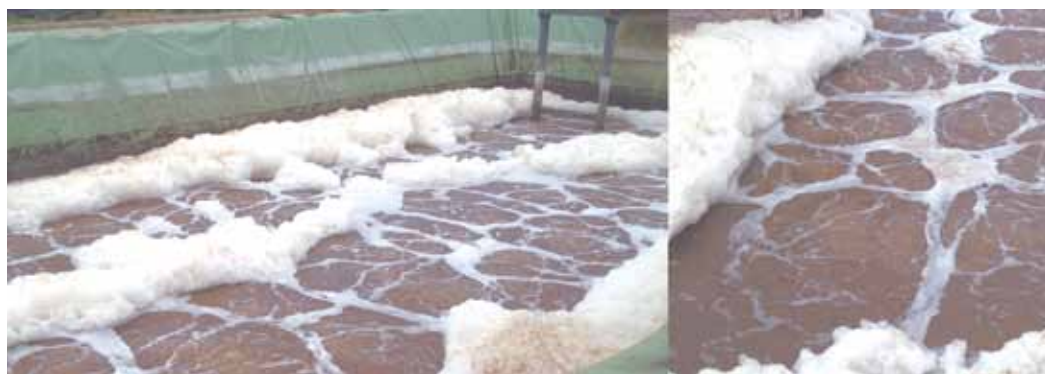
Рис. 4. Пенообразование в аэротенке в результате сбросов стока убойного цеха мясокомбината
