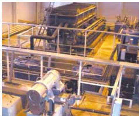
Рис. 2. Сооружения физико-химической очистки сточных вод птицефабрики
