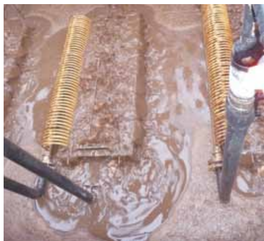
Рис. 1. Очистные сооружения с МБР-технологией, плоскостные МБР-модули в работе
